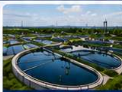
TRAITEMENT DES EAUX
